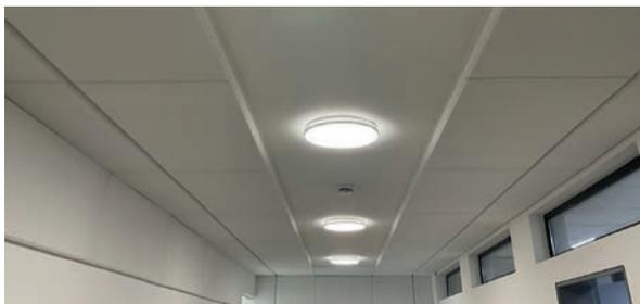
In der Kita Bicken wurden die benötigten Schallschutzplatten an den Decken und Wänden von einer Fachfirma angebracht.
