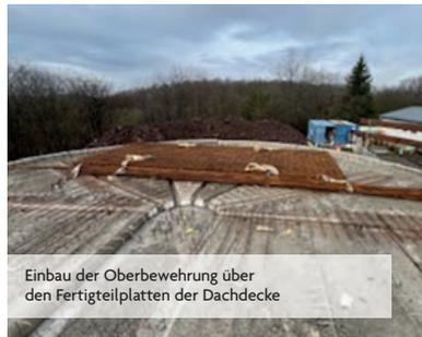
Einbau der Oberbewehrung über den Fertigteilplatten der Dachdecke
