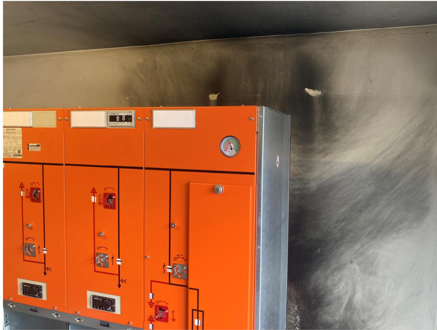
Kleine Ursache, große Wirkung: Eine geplatze Kupplung eines 20kV-Ölkabels in der Trafostation.
